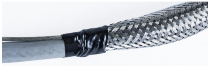
Figura 2-54: Revestimento externo fixado com fita elétrica
