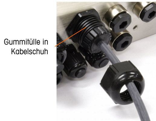
Abbildung 2-27: Gummitülle in Körper des Kabelschuhs
